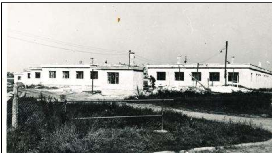
A Beszédes utcai telephely építése közben 1969-1970 körül. 61
